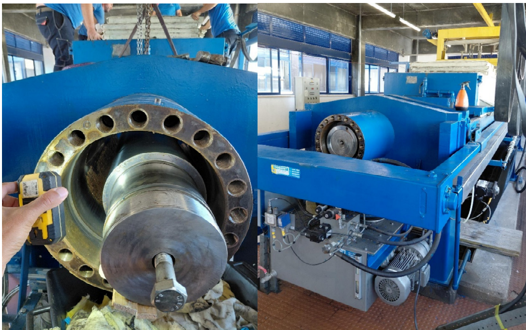
Figura 6 - Desmontagem do Sistema Hidráulico da Prensa B da ETA de Tavira
