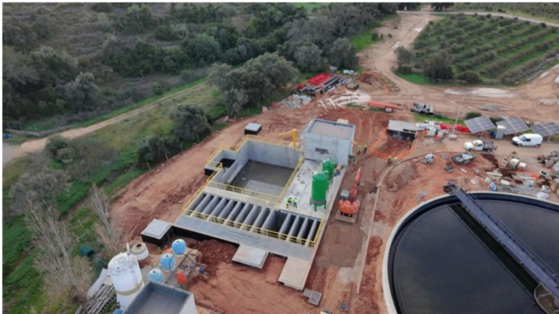
Figura 11 - Execução de Infraestruturas de Elevação e Adução ApR – ETAR de Albufeira Poente (PRR) – Instalação de equipamentos e trabalhos de movimentação de terras.
