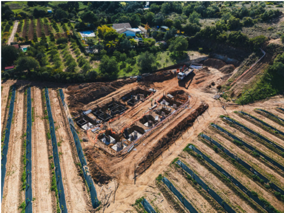
Figura 10 - Reforço Ligação Sotavento/Barlavento – 1ª Fase – Torre e Estação Elevatória do Cascalho – Trabalhos de betonagem e montagem de armaduras.
