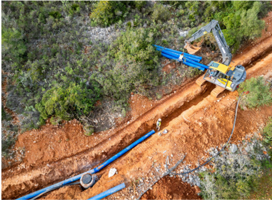
Figura 9 - Fases de Reforço de Adução a Loulé - Fase III – Instalação de conduta em vala.
